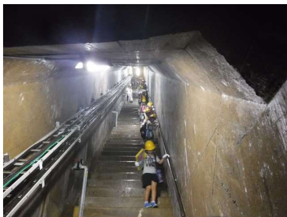
ダムの中（監査廊）を移動中
