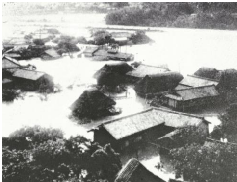
城辺町北裡の洪水状況
